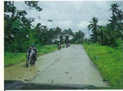
写真 8-国道(コンクリート舗装)
