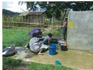
写真 9-村落給水施設
