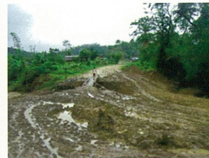
写真4-雨期の既存道路
