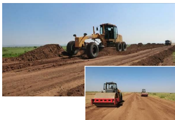
盛土工事写真
