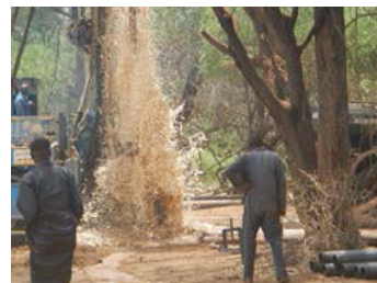
井戸掘削に成功後、噴き上がる地下水
