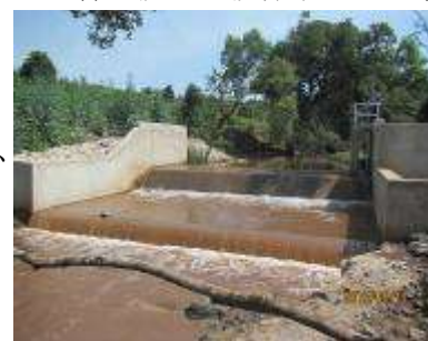
完成した取水堰
