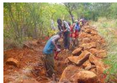
農民参加型建設工事
