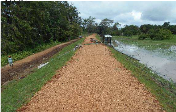
連結水路のサイフォン区間
