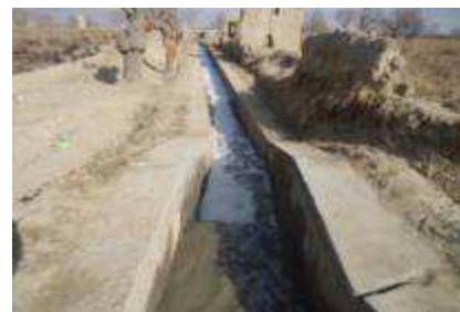
パイロットプロジェクトサイト（デザブ）の改修水路
