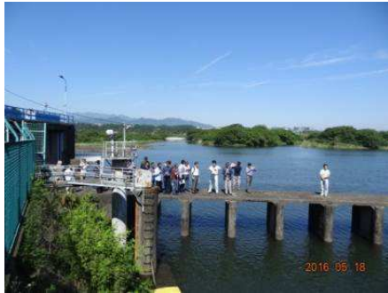
神奈川県 磯部頭首工の見学
