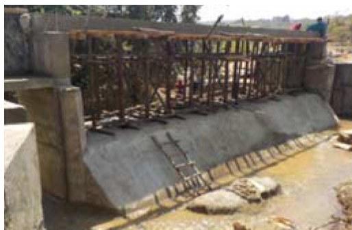
頭首工（固定堰）工事の状況
