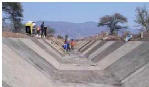
コンクリートライニング工事の状況
