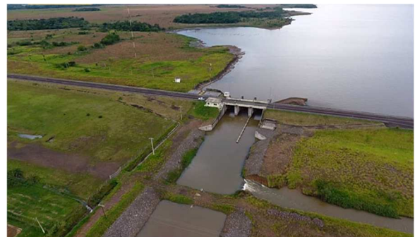
写真：ヤシレタダム湖からの取水工（調査団撮影）
