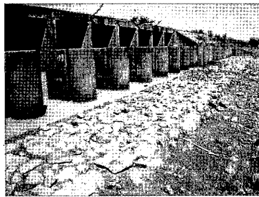
地下ダムへの浸透堰
