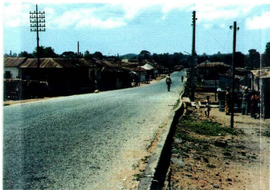
スエドロ地区国道16号線 Root 16
