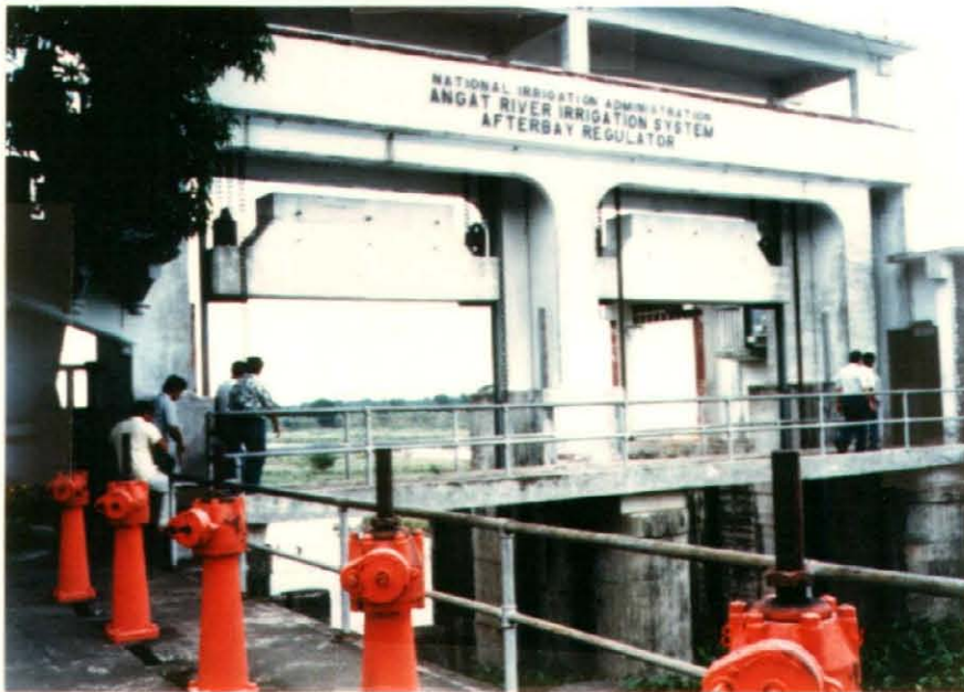
Angat-Maasim River Irrigation System (AMRIS) の起点 Bustos頭首工
