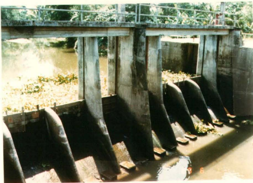
マッシム下流頭首工 （下流側）
