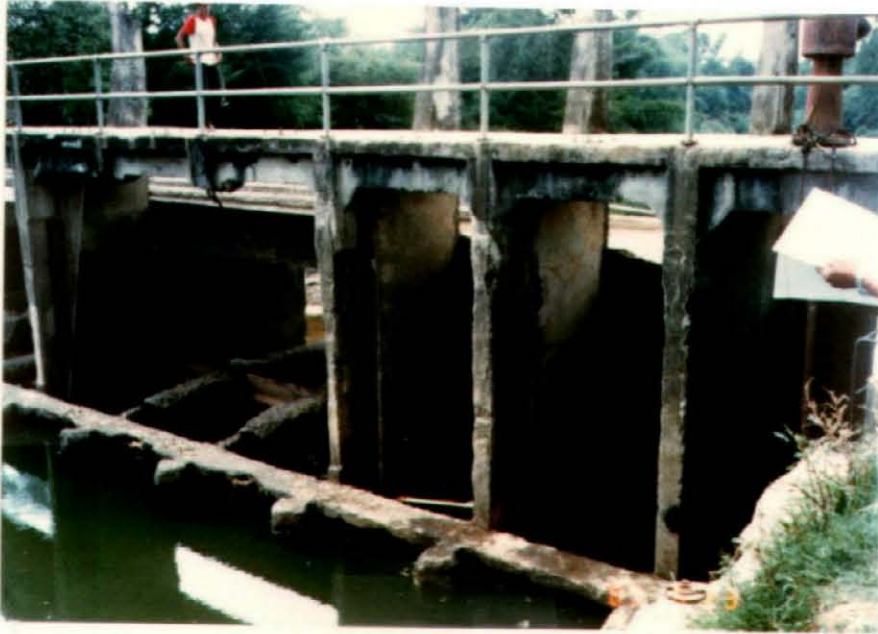
マッシュム上流頭首工 (上流側)
