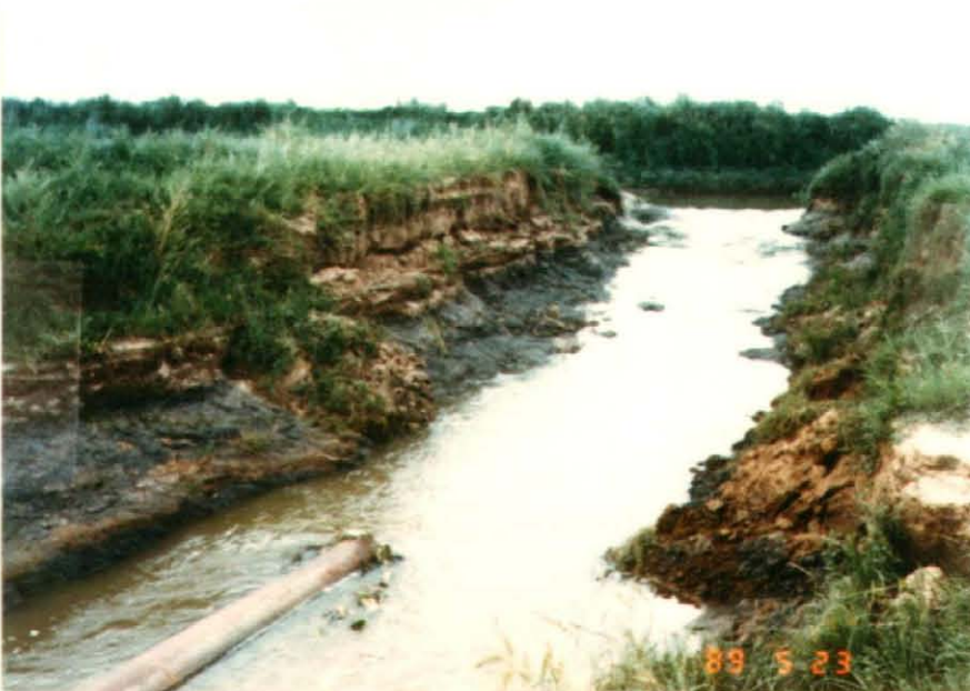
マッシュム第3頭首工 建設予定地点（上流側）
