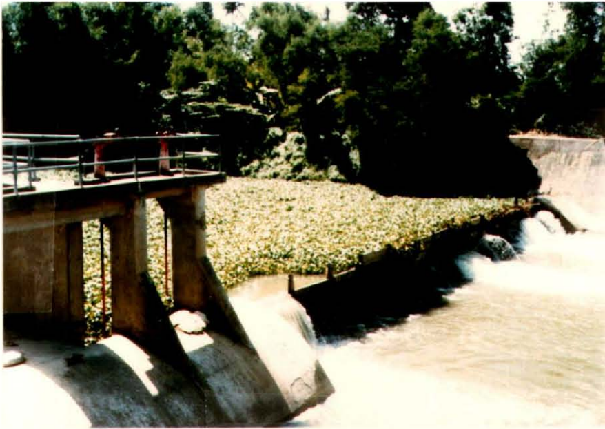
シノカラン頭首工 木製のストップログ にて堰上げしている
