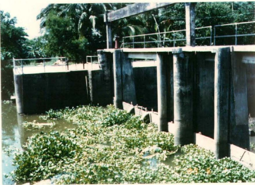
マッシム下流頭首工 （上流側）
