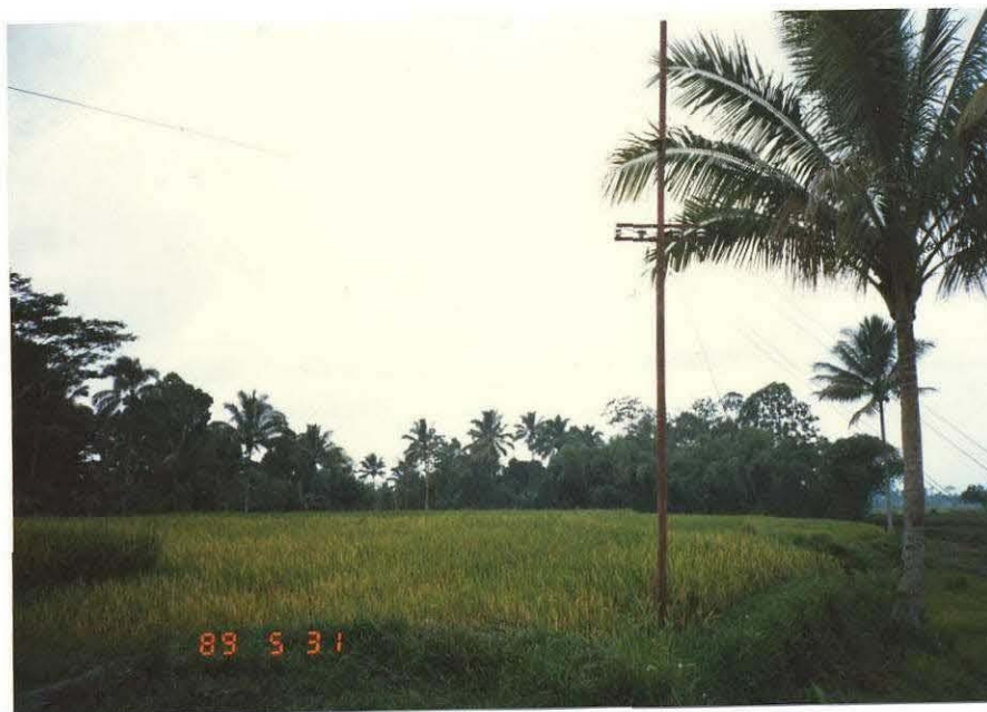
既存配電線状況
