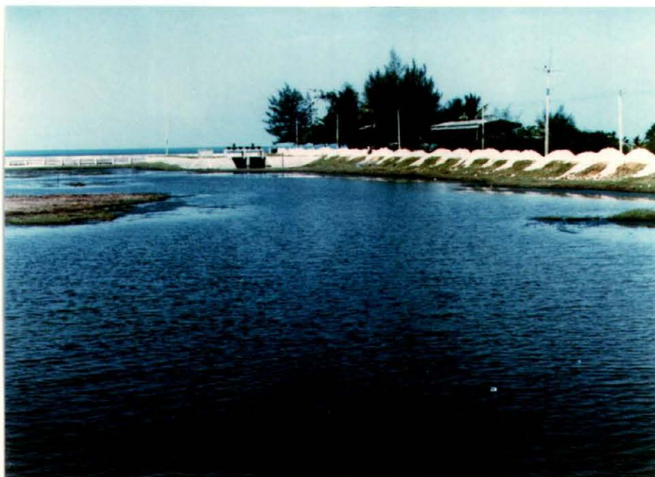
海岸部 排水用構造物 (角落し及びゲート工)
