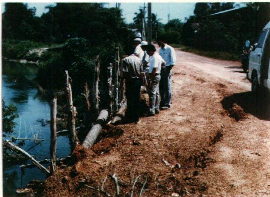
河川屈曲部 洗堀防止工
