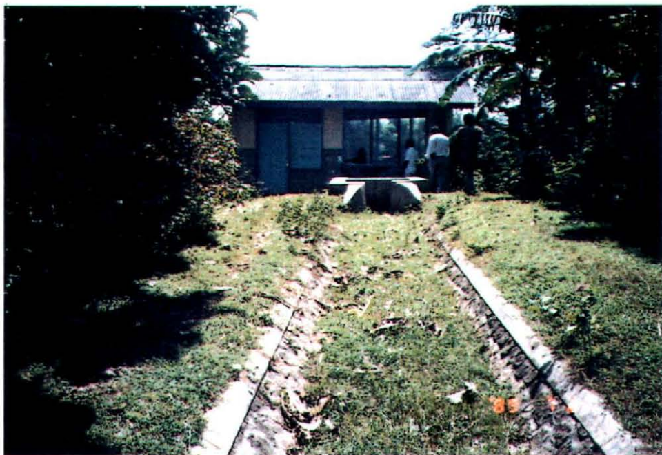
⑦同上機場の吐出側
