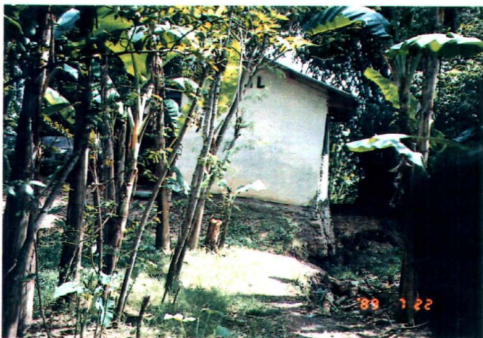
⑩同 上 ポンプ室も傾いている
