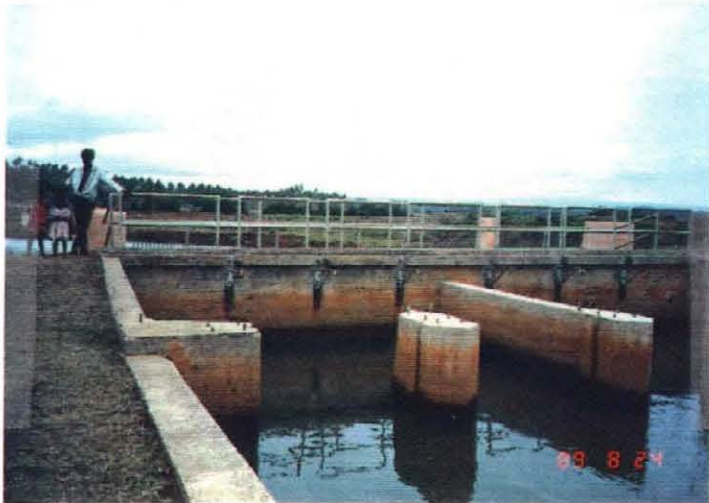
灌がいプロジェクト排水路末端 (フラップ弁)
