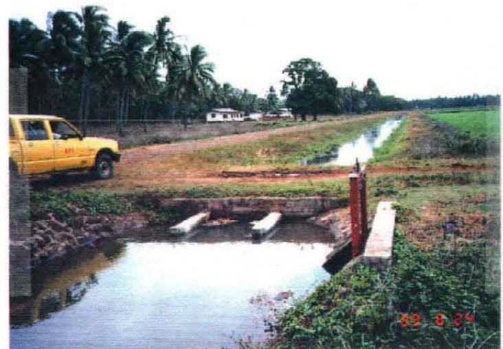
灌がいプロジェクト幹線用水路
