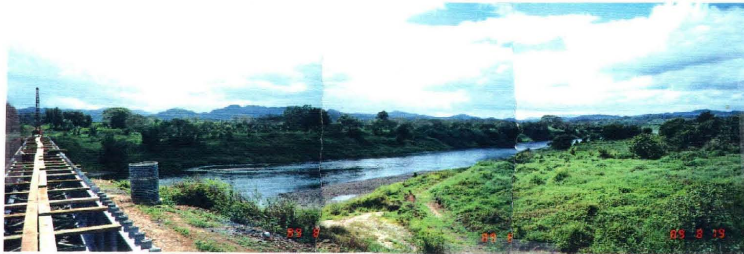
地区下流側及び左岸側状況
