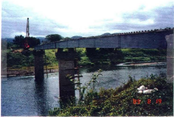
PWD(公共事業省)により建設中の橋梁
