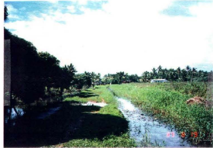
地区排水不良状況
