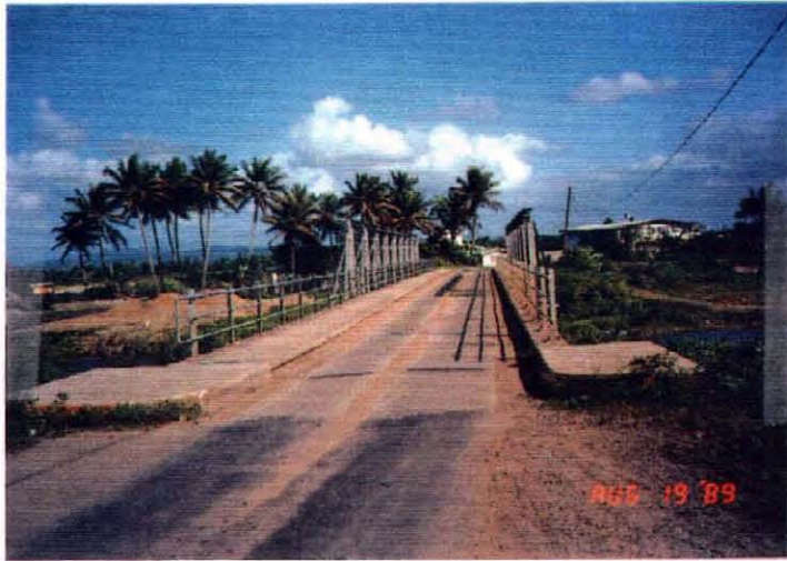
ADP により最近完成したWAINIBOKASI 川橋梁
