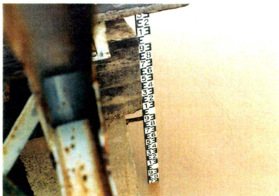
Xe Xangxoy川の量水標（11号道路橋の下）
