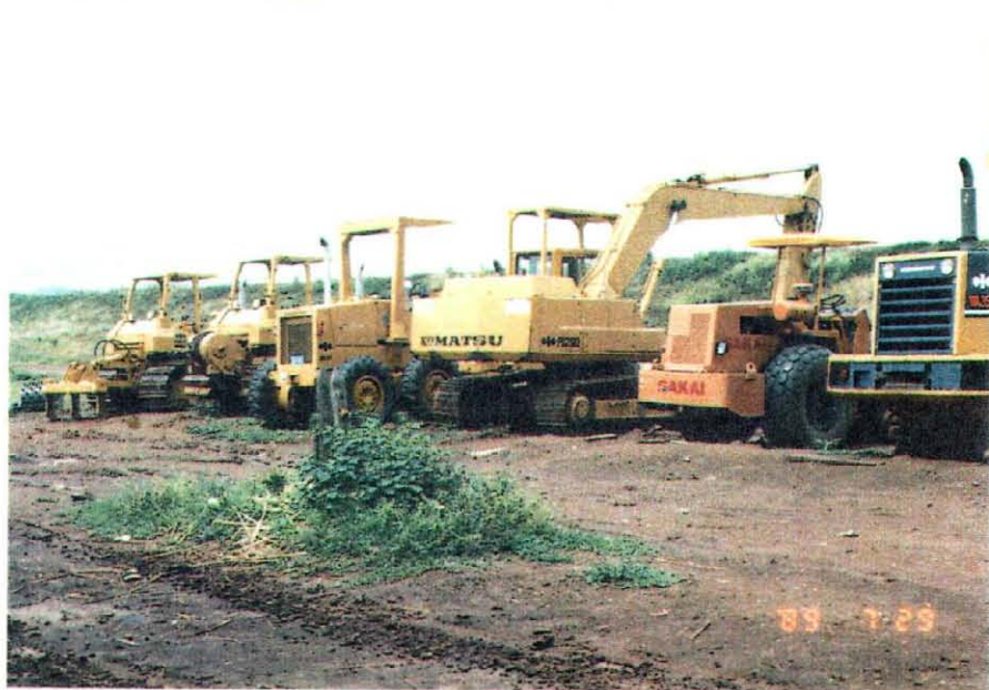
灌漑ダム建設用の土木機械
