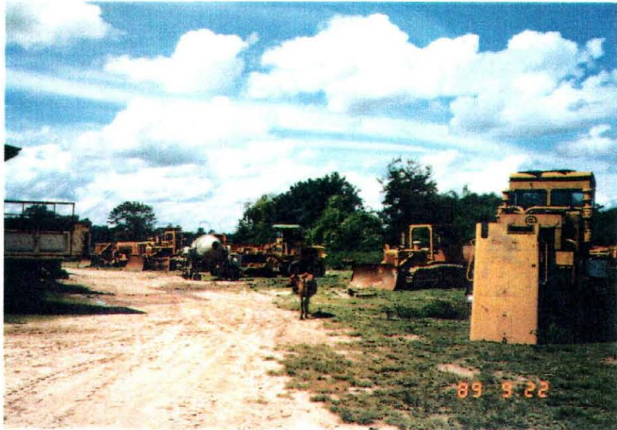
灌漑ダム建設用の土木機械
