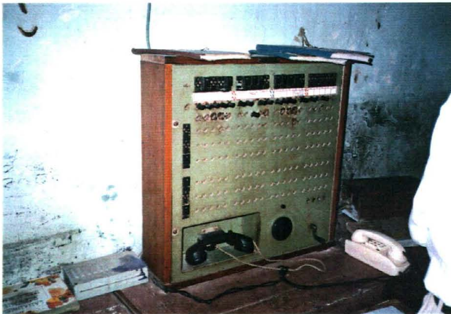
2) コトリ地区既存通信装置 (老朽化し、殆ど使用されてい ない)
