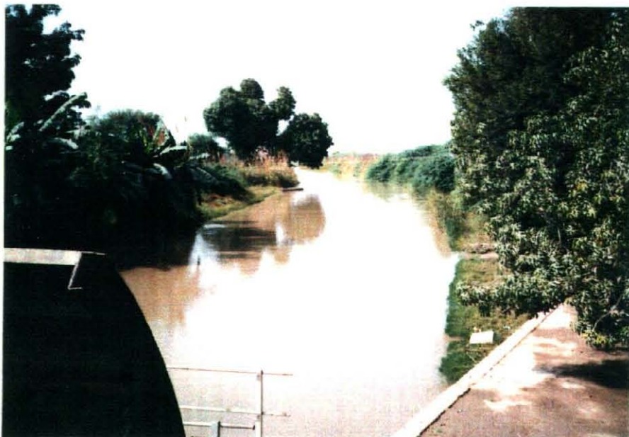
3) マキ〜ファラシ間ナラ 幹線水路の 現況
