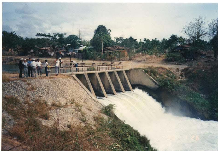
写真5 BAGONG SICAT 取水堰
