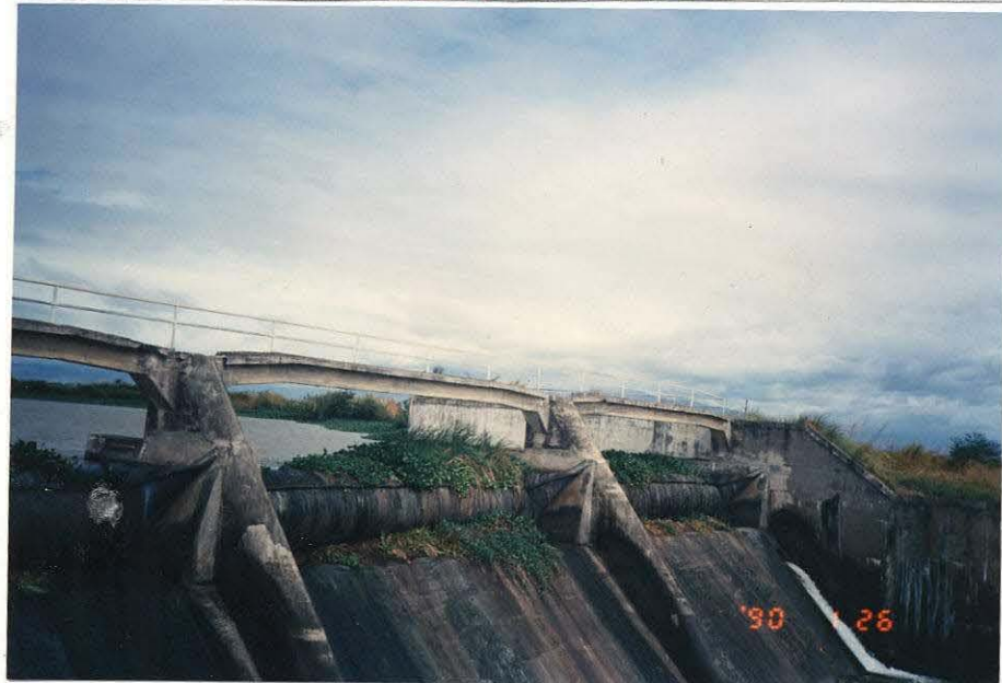
写真6 VACAダム (ゴム堰)
