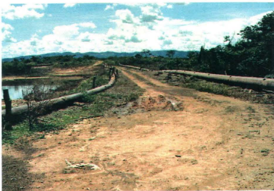
導水パイプライン
