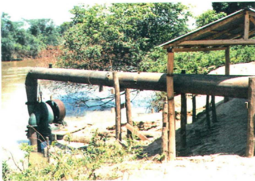
灌漑ポンプ場
