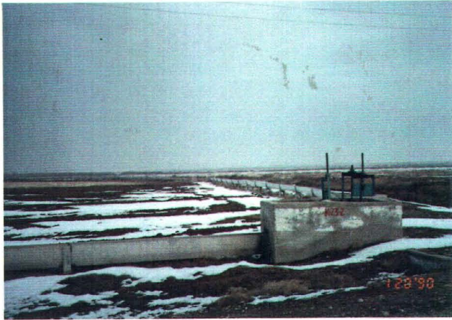
コンヤ平原におけるコンクリートフリュームによる灌漑 - 1
