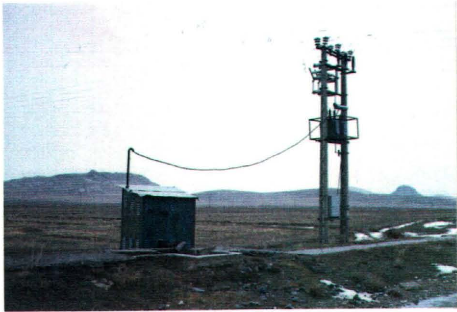
地下水利用によるポンプ灌漑（ジュムラ地区）
