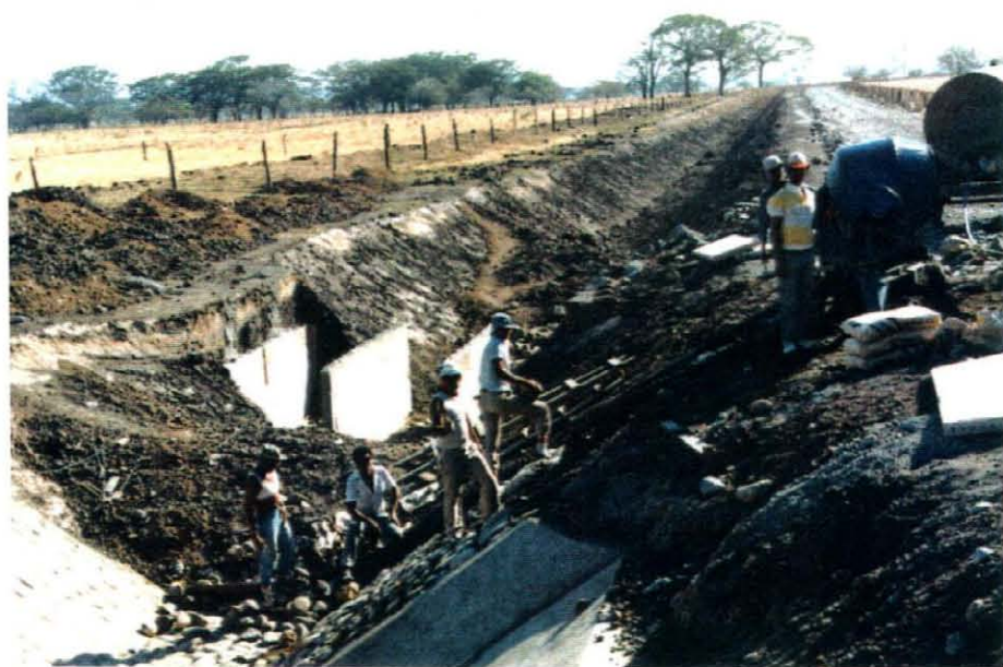
(4) 南部、カーニャス地区支線水路工事 落差工の下流側
