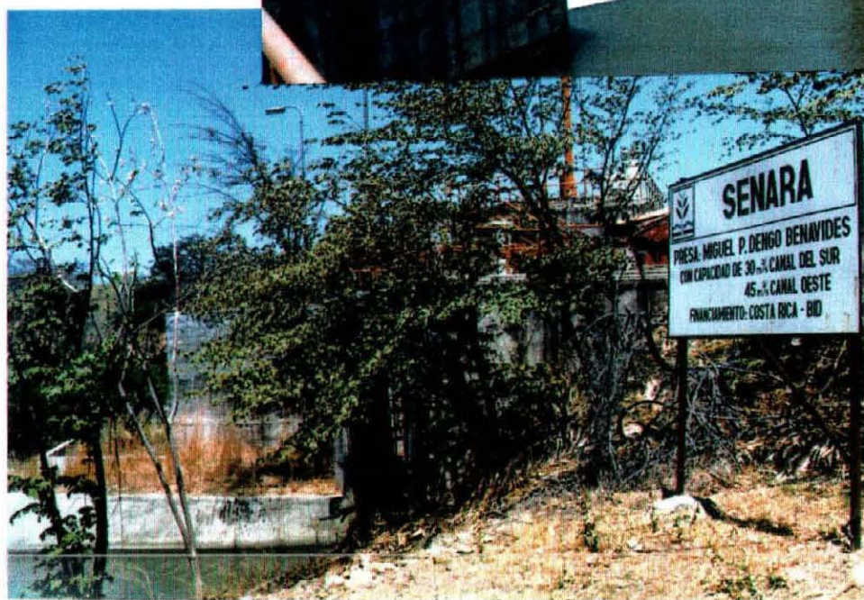
(2) マグダレナ取水堰 右岸側 南部幹線 水路側
