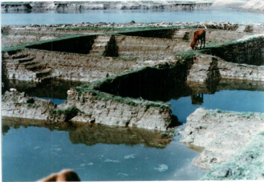
締切りのための土取場
