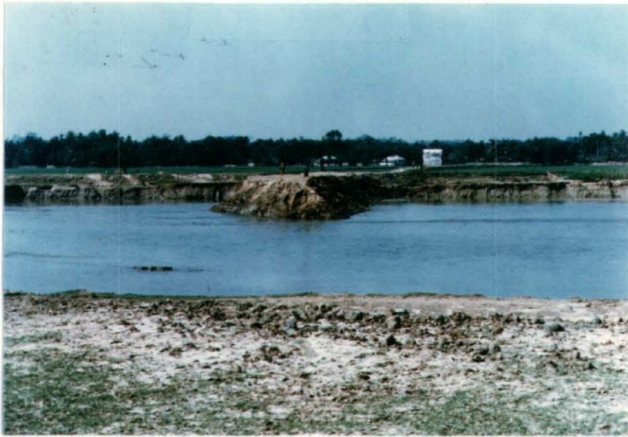
乾期の塩水遡上防止の締切り
