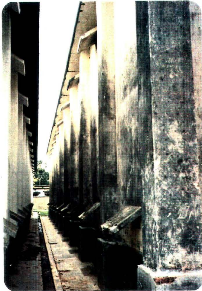
3-3 貯蔵庫の換気 : 自然通風による換気
