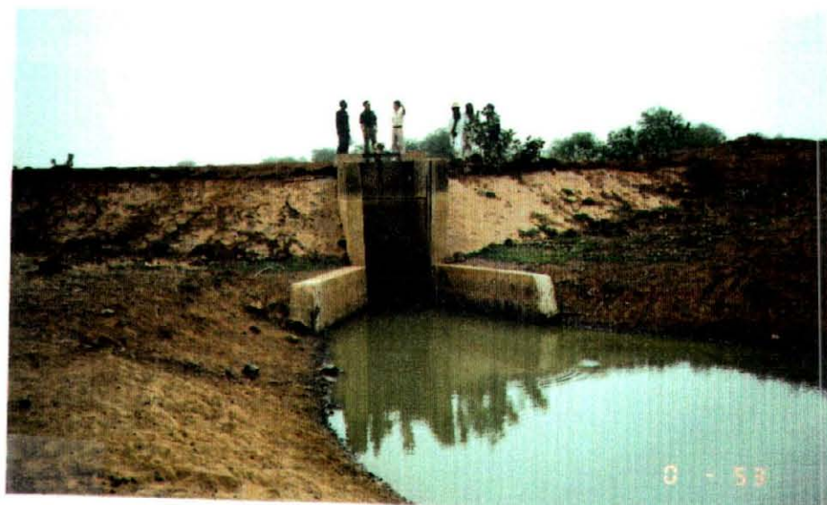
開發地区 取水樋門
