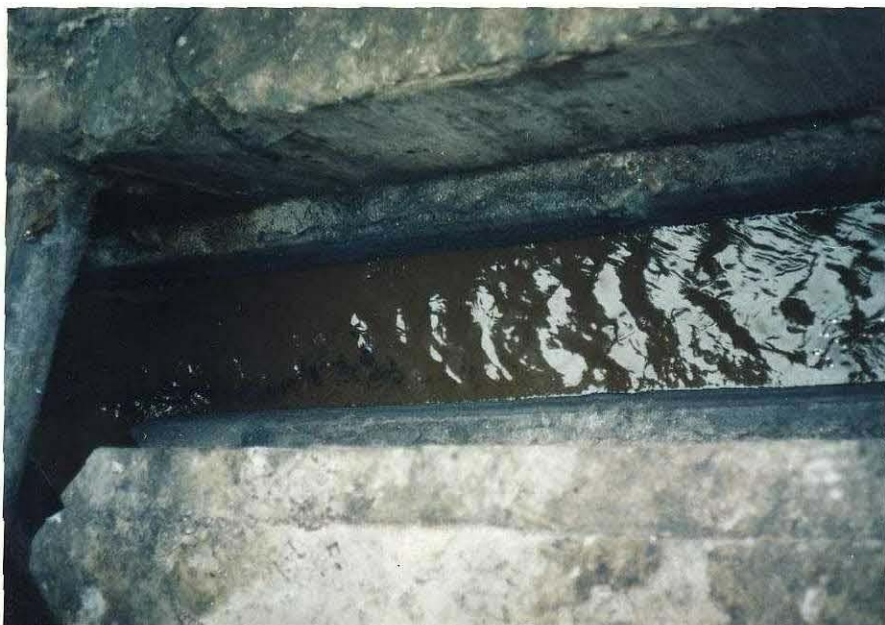
9. 旧式な設備では排水中に 損失油が流失する。
