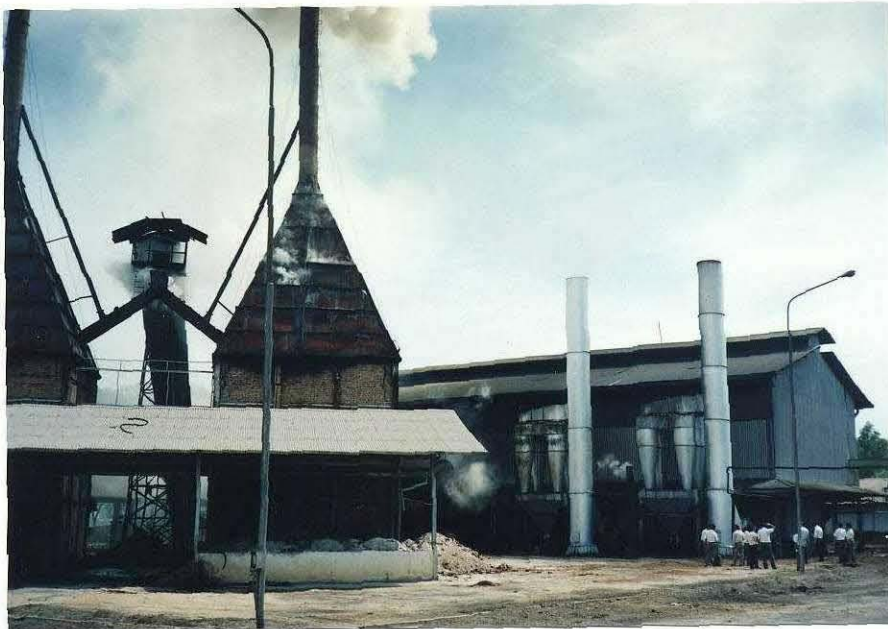
8. 既存の核エステートには 搾油工場があり、稼動してい る（メダン近郊）。
