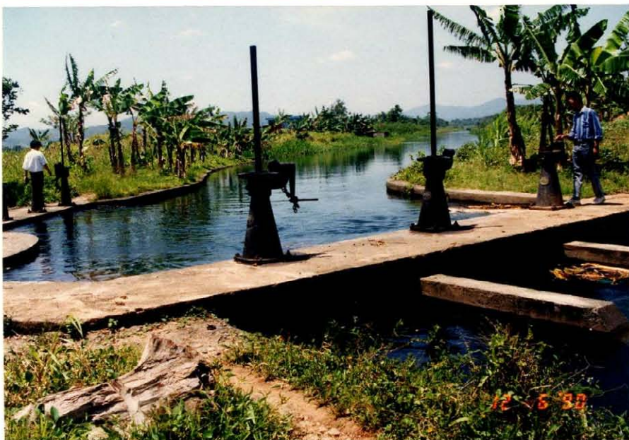
Canal Yuna 分水工 (用水は潤沢にある)
