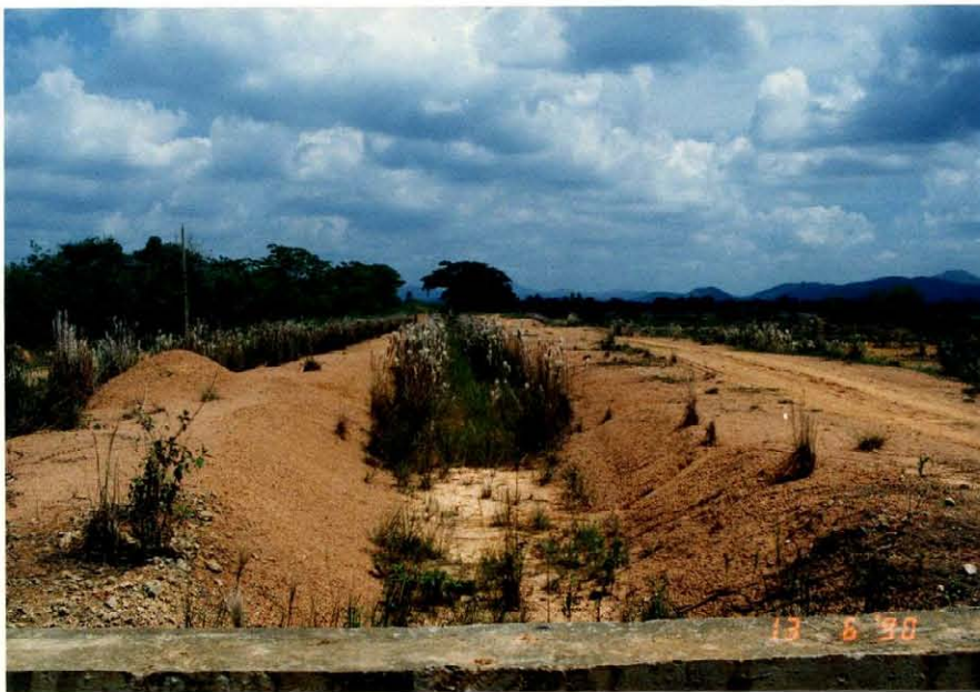
La Savita 水路 10数年前に工事を開始したが、 建設途中にて中断となった。
