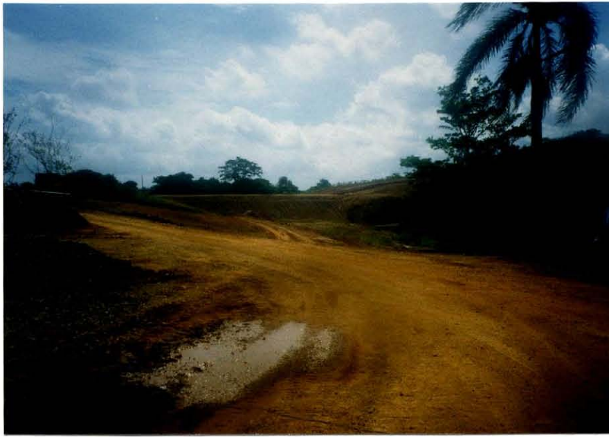
現在建設中のEl Mijo ダム 当ダムは Estrella 地区を灌漑 予定であるが水路はまだ建設 されていない。
