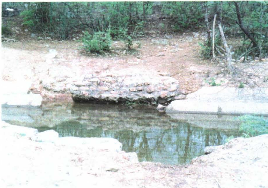
幹線用水路の（コンクリートライニング）の損壊状況
