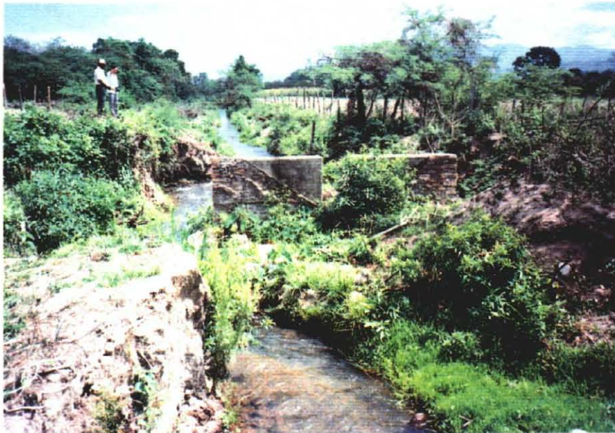
幹線用水路（土水路）の損壊状況
