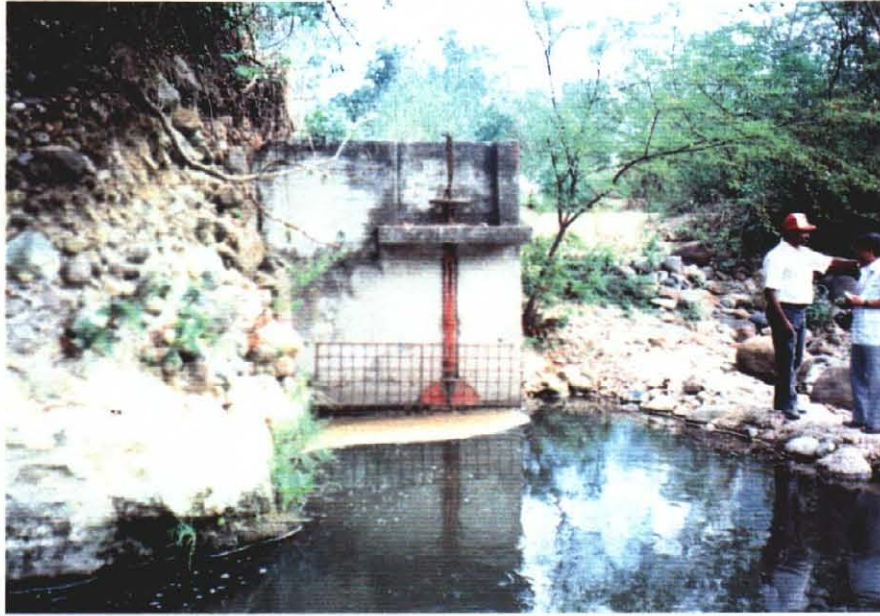
グランデ川の石積み堰による取水施設
