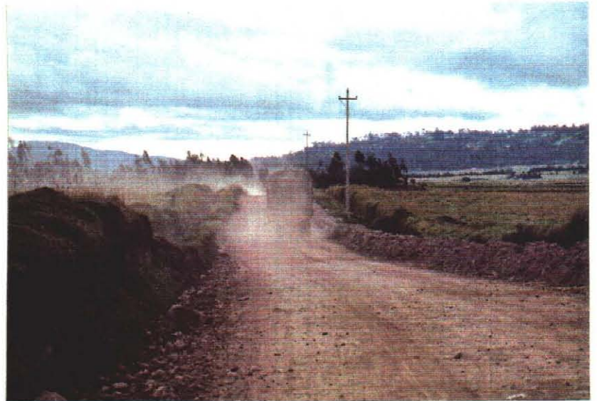
未舗装の地区内幹線道路 →
