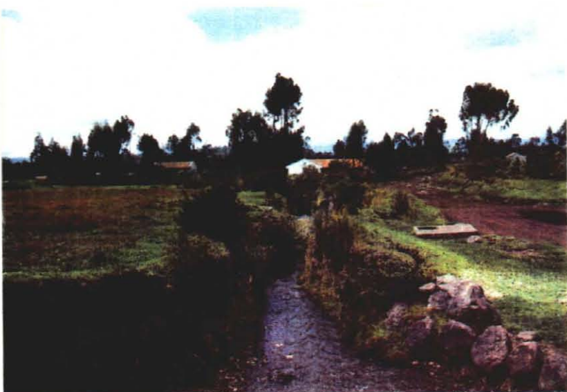
← 地区内支線用水路
