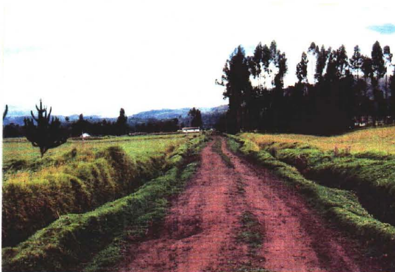
← 農道と両側排水路
