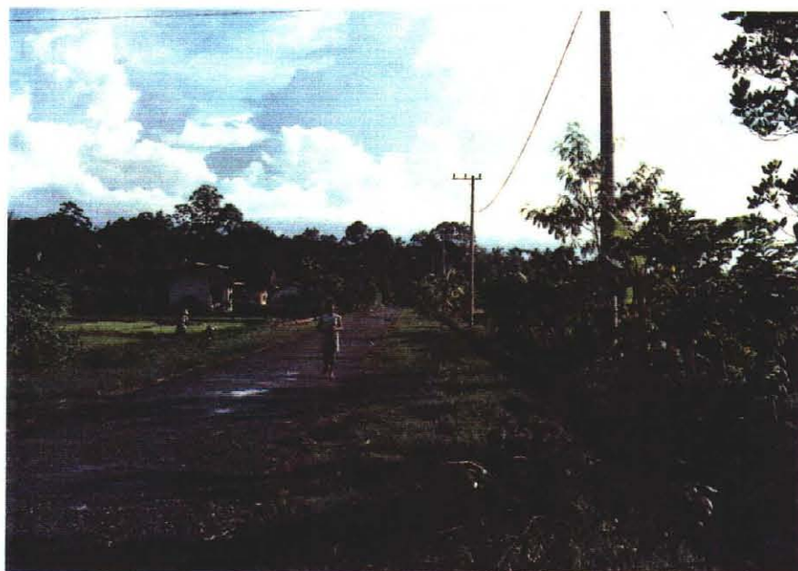
ルンパケ地区 基幹道路
