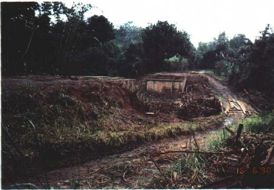
4. 橋梁破損状況, イボロワナ川右岸
