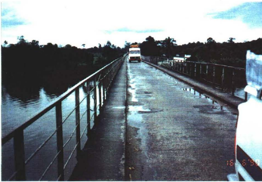
7. 国道5号線, イボロワナ川橋梁
