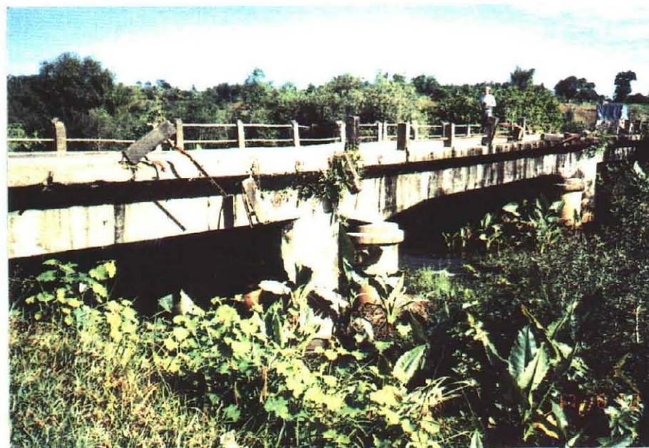
9. 国道2号線橋梁, イボロワナ川左岸
