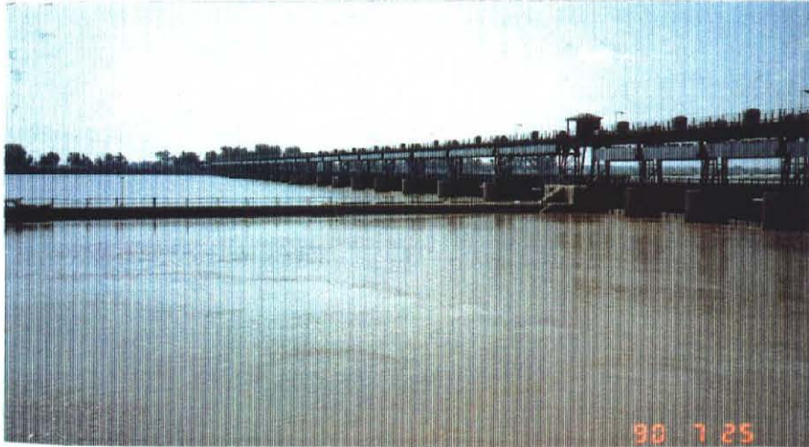
サレマンキ頭首工
