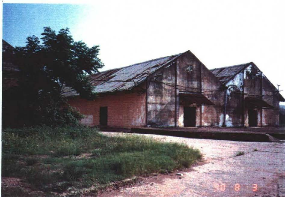
キエン・アン地区 既存倉庫
