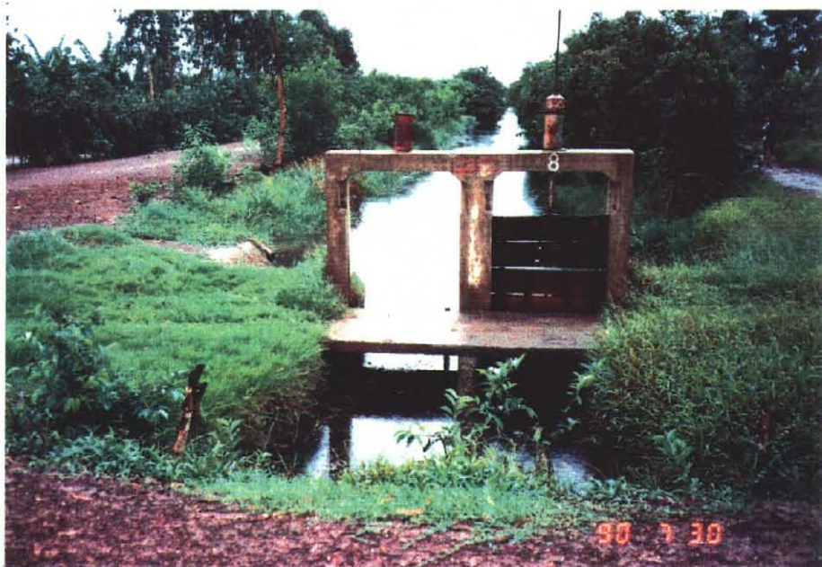
アン・ハ川 取水ゲート
