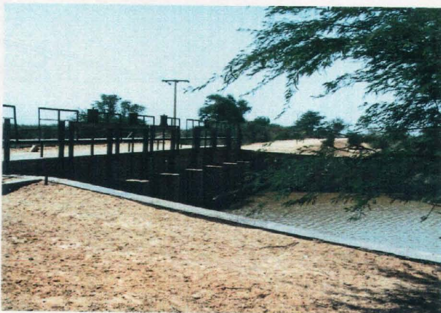
Système Gravitaire de Pompage. N'est pas actuellement utilisé dû à l'élévation du lit du Canal.
