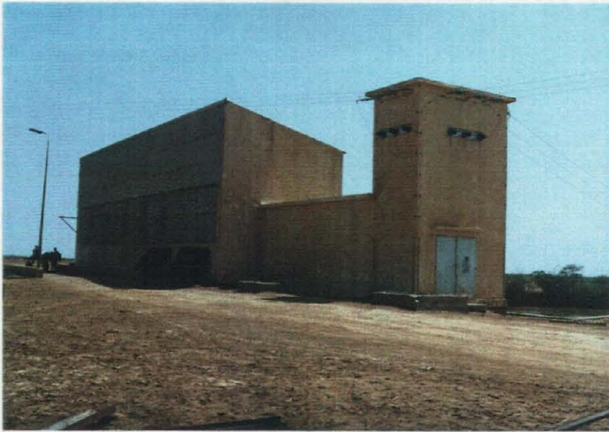
Station de Pompage de Rong.
