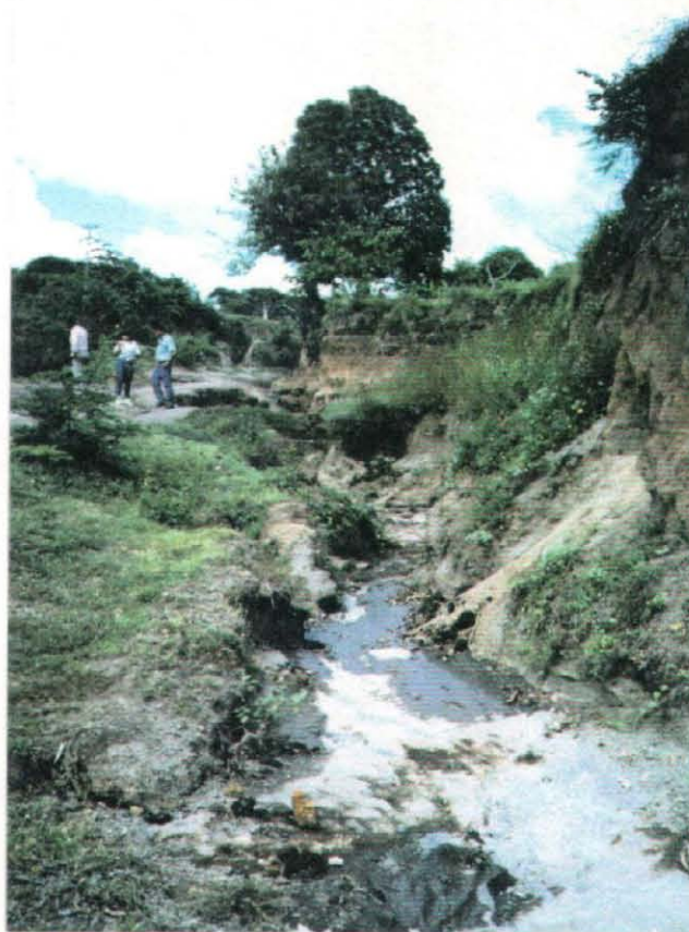
侵食によって発生している小溪流（Arroyo）
