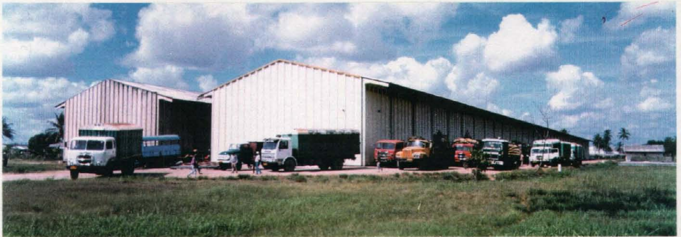
① ダルエスサラームにある穀物倉庫（12,000トン×2種） 同様な倉庫の建設が望まれている。
