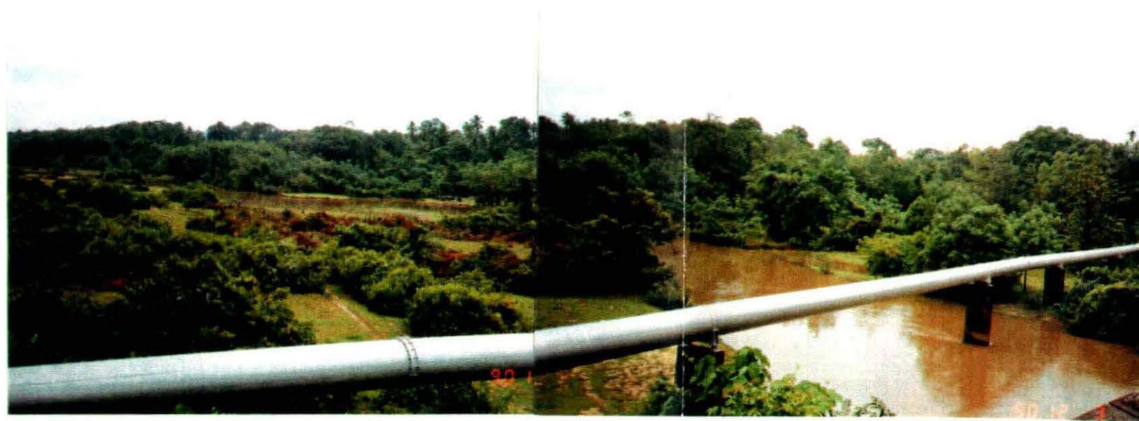
国道(A4)33kmポスト付近から 地区内下流側を眺む
