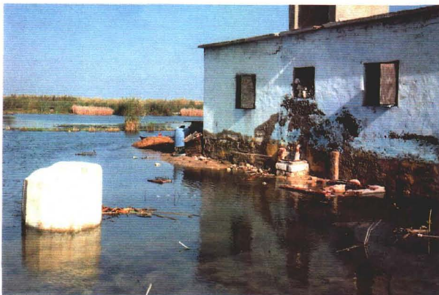
湛水の被害を受けている 周辺民家(オモウム地区)
