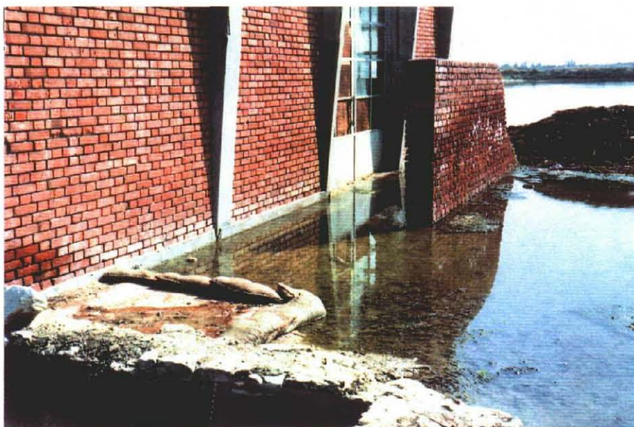
漏水の顕著なエルハリス ポンプステーション (オモウム地区)
