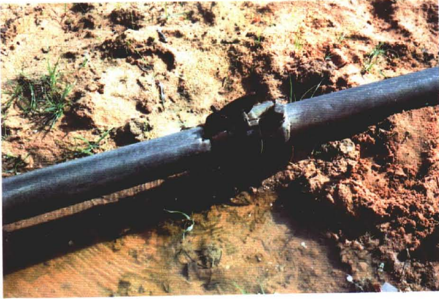
漏水のひどい パイプライン(プスタン)
