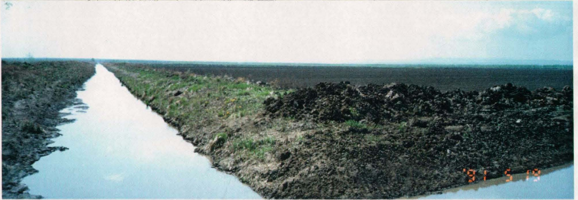
850 国営農場内 低湿耕地での明渠による排水状況
