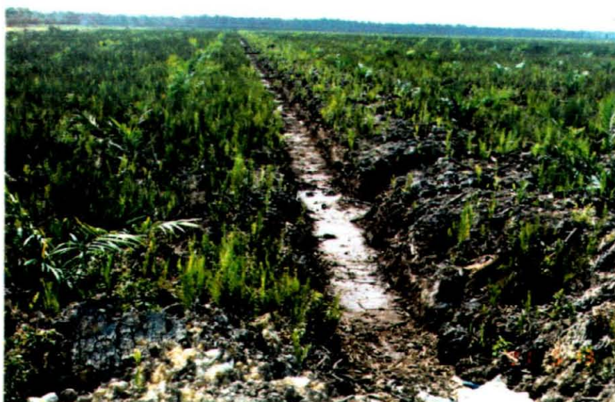
3) 圃場内湛水排除対策 (末端圃場レベル排水溝)
