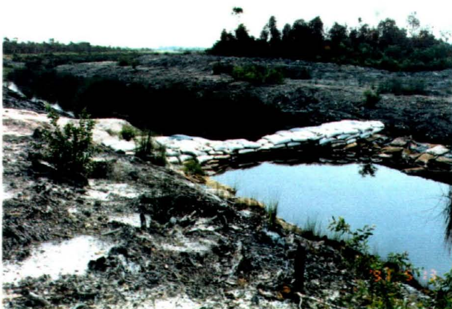
2) 過剰排水による 地下水位低下防止の 対策 (サント・ハック仮堰上げ)
