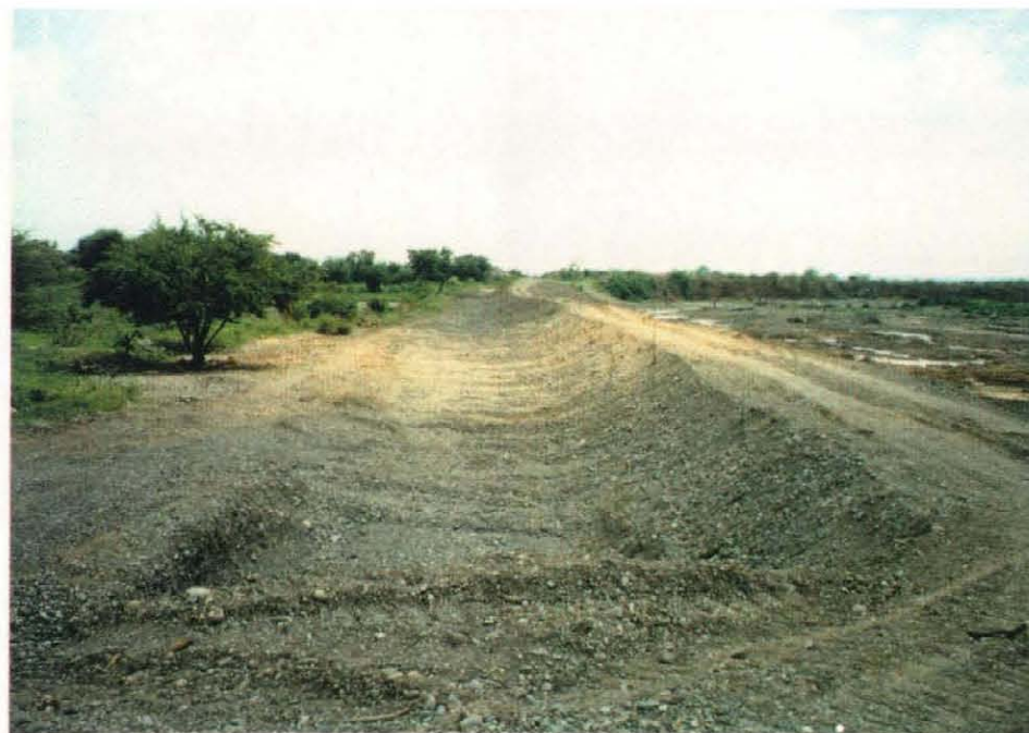
1991年5月 ディパロRIS 主要幹線水路 応急処置として作られた水路
