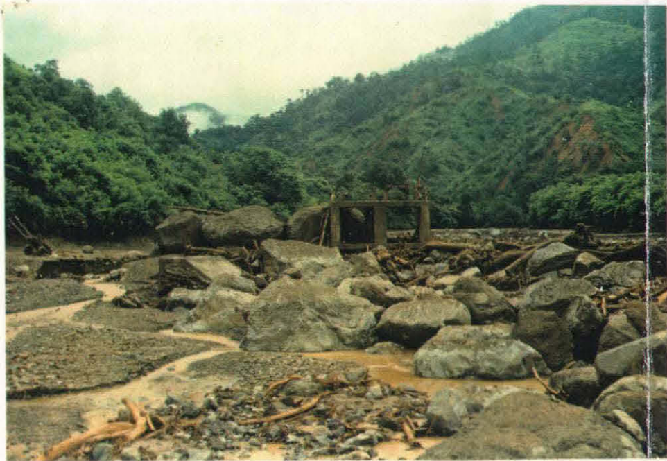
1990年7月 プリンシパルCIS取水施設 流出した土石によって崩壊した取水施設(下流より)
