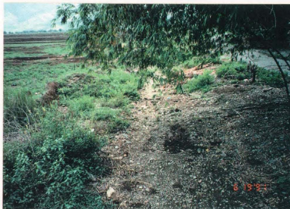
1991年5月 ディパロRIS 主要幹線水路 堆砂の著しい水路
