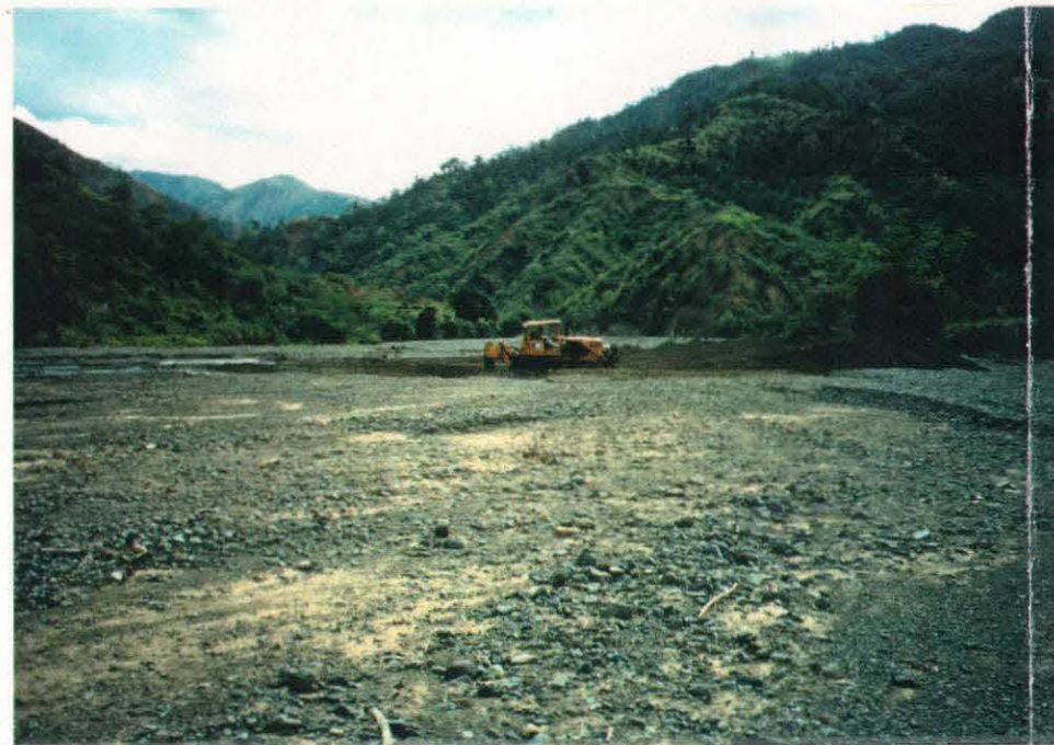
1991年5月 同 上 取水施設は流出した土砂によって完全に埋め尽くされた。
