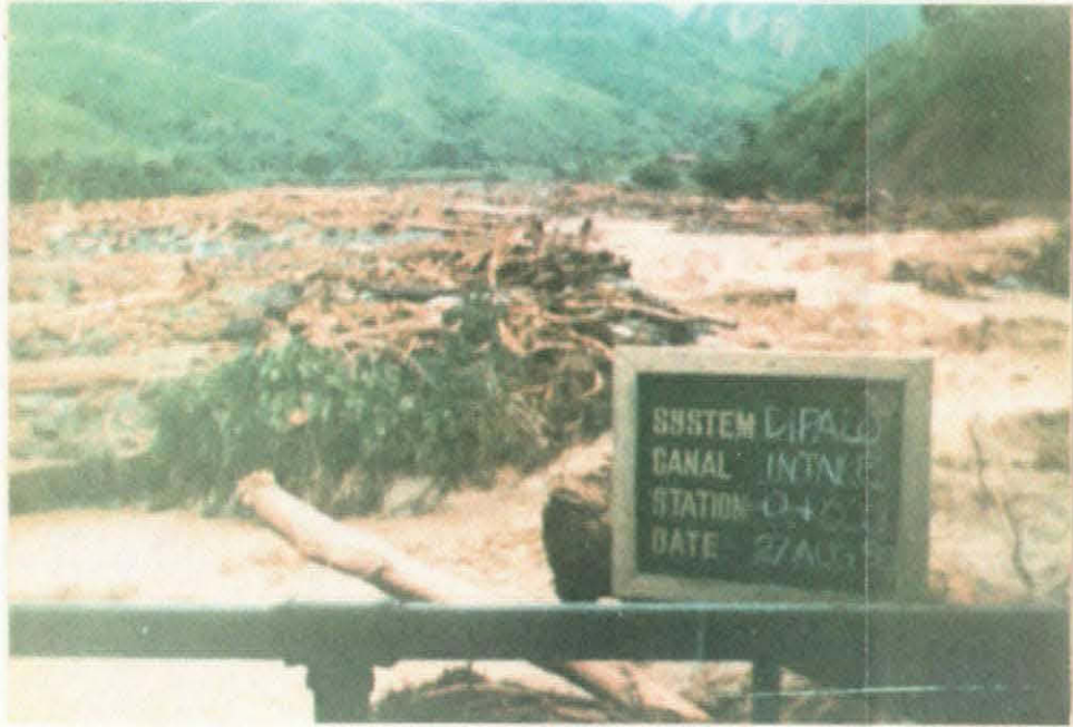
1990年8月 同 左 大地震発生より1ヶ月後、大量の流木・土砂が上流より流出している。
