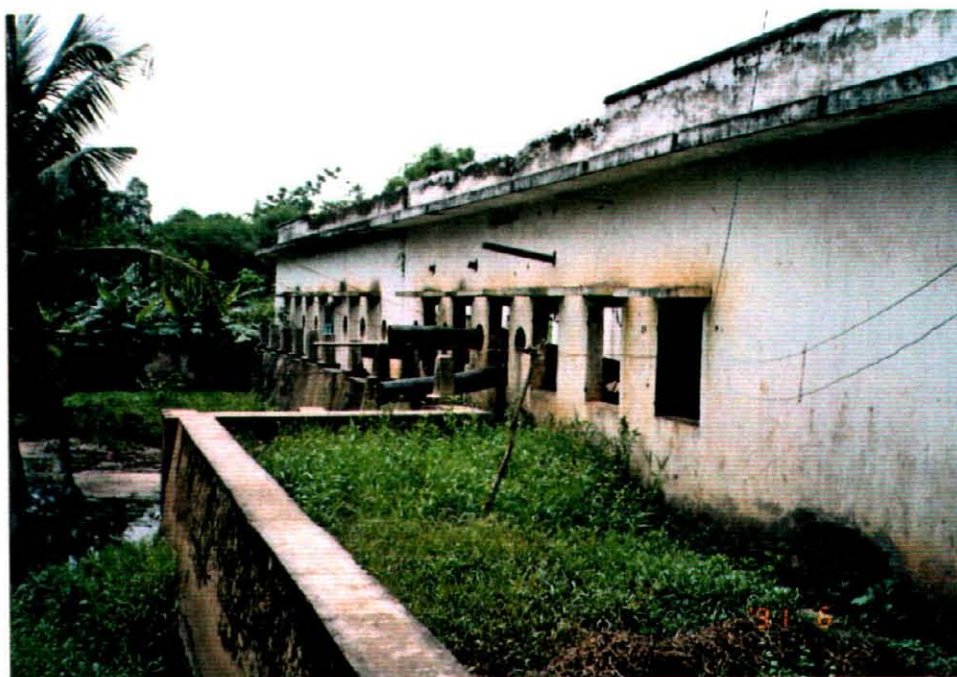
ロンアン省内の老朽化したポンプ場
