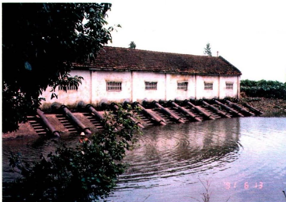
ハイフン省内のビンディ排水ポンプ場 ( \phi 300 @ 12 台 排水容量 = 1,000 m^3 / 日)
