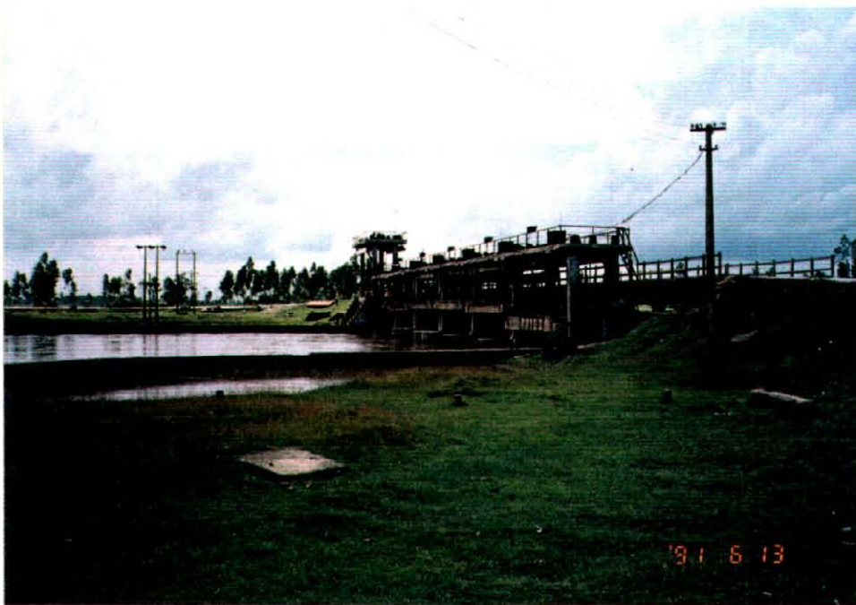
ハイフン省内のカンゼア (Can Xea) 防潮排水樋門 (排水量 Q = 230 \text{ m}^3 / \text{sec} )
