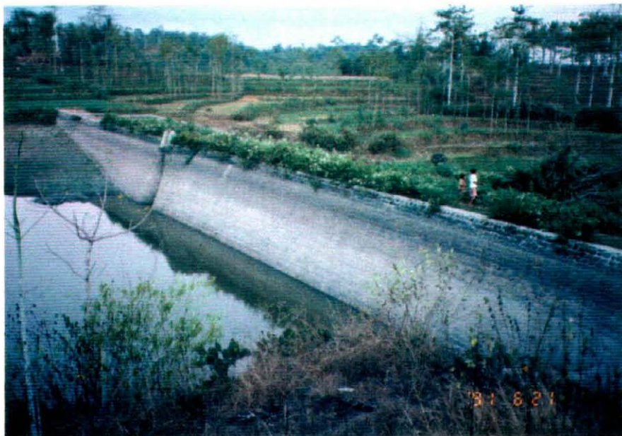
- Gusi Embung 村単位で管理している溜池。 灌漑面積：200 ha 貯水量：82,500 m 3
