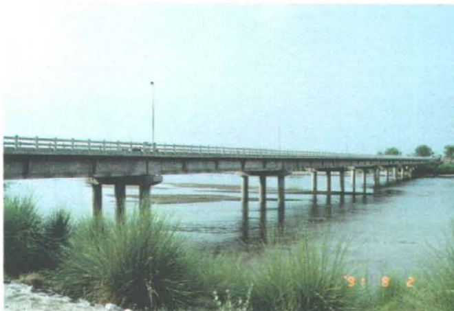
⑩ Chichawatni 橋側面（コンクリート製）
