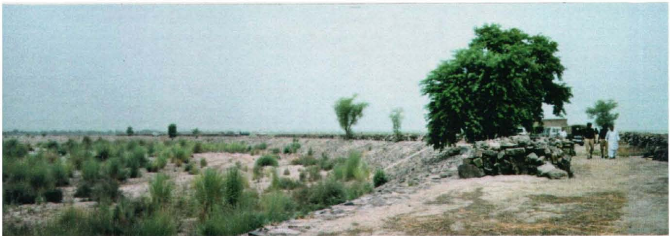
① 既存水制工 (Spur)
