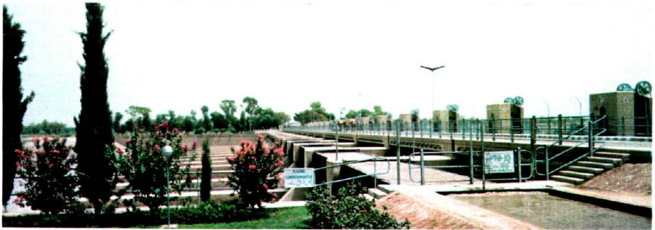
⑬ 下流側の Shidnai Barrage、全長 216m（大洪水時には容量不足となる）
