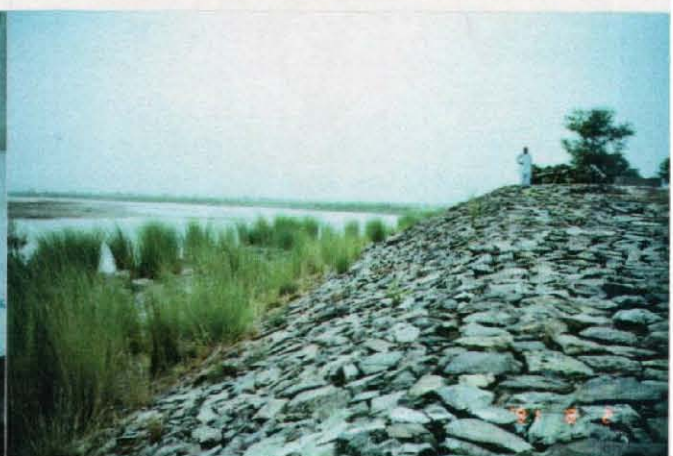
③ 水制工の石積法面 (石が近隣になくコストが高い)
