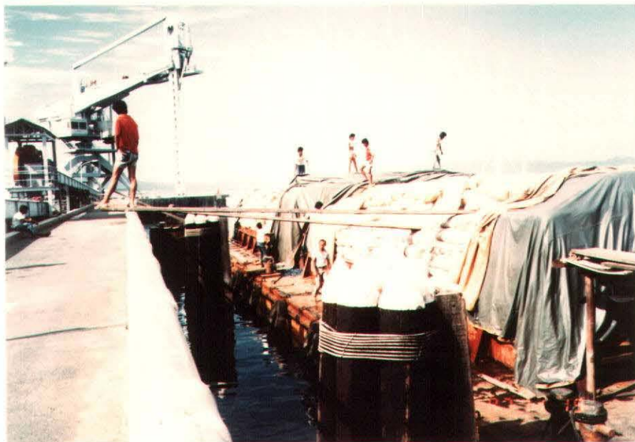
(8) バタンガス港に着岸した民間よりリース した500トンバージ船
