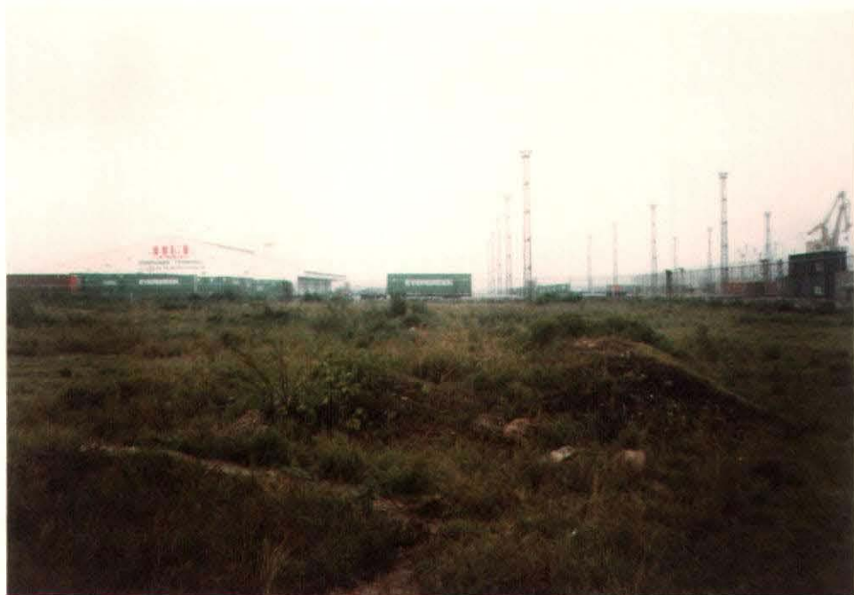
(14) NFAセブー港内アンローディングターミナル 建設予定地
