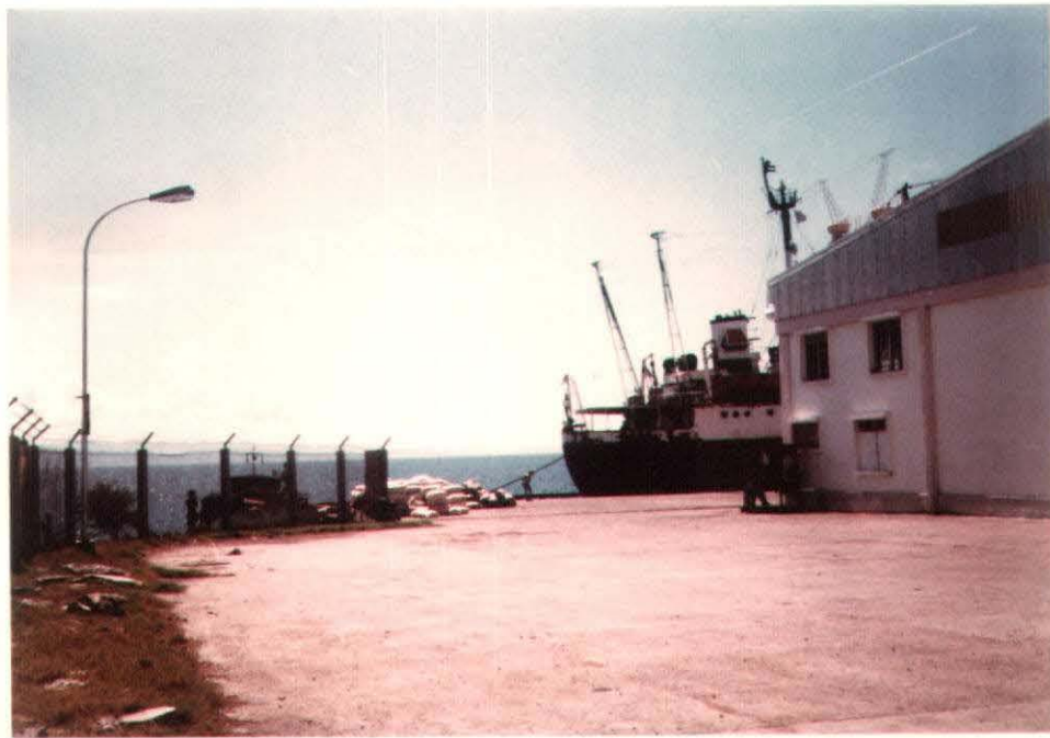
(11) ゼネラルサントス市マカール港NFAローディングターミナル建設予定地
