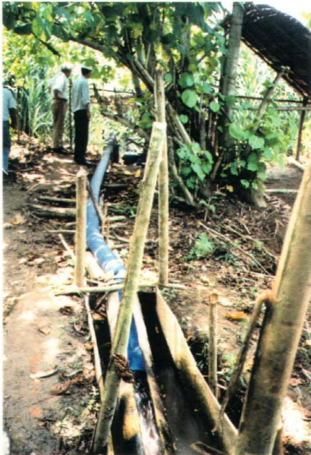
NO. 4 バイドンド地区のポンプ灌漑施設
