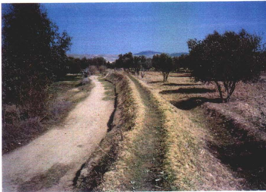
(8) セブー川中流域地区Ⅱ左岸ウル ジャ G 11→ G 10 可搬式ポンプによる揚水を灌漑 に利用するための土水路
