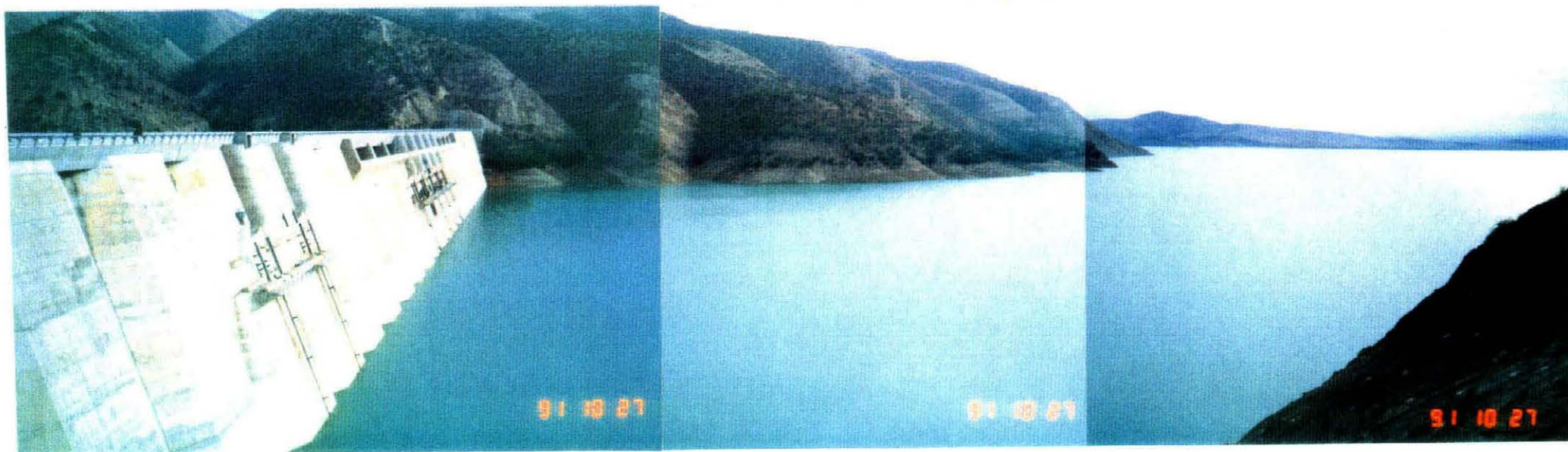
(18) イドリス第1ダム及び貯水池
