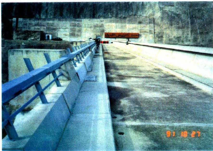
(17) イドリス第1ダム天端
