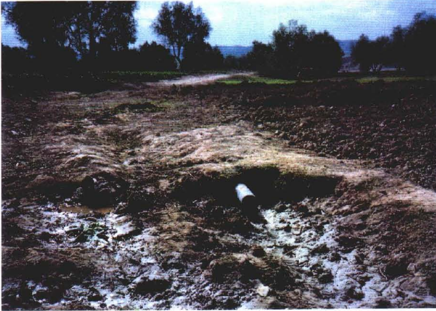
(7) セブー川中流域地区Ⅱ左岸ウル ジャ G 11 可搬式ポンプによる揚水を水路 に連絡する埋込パイプ
