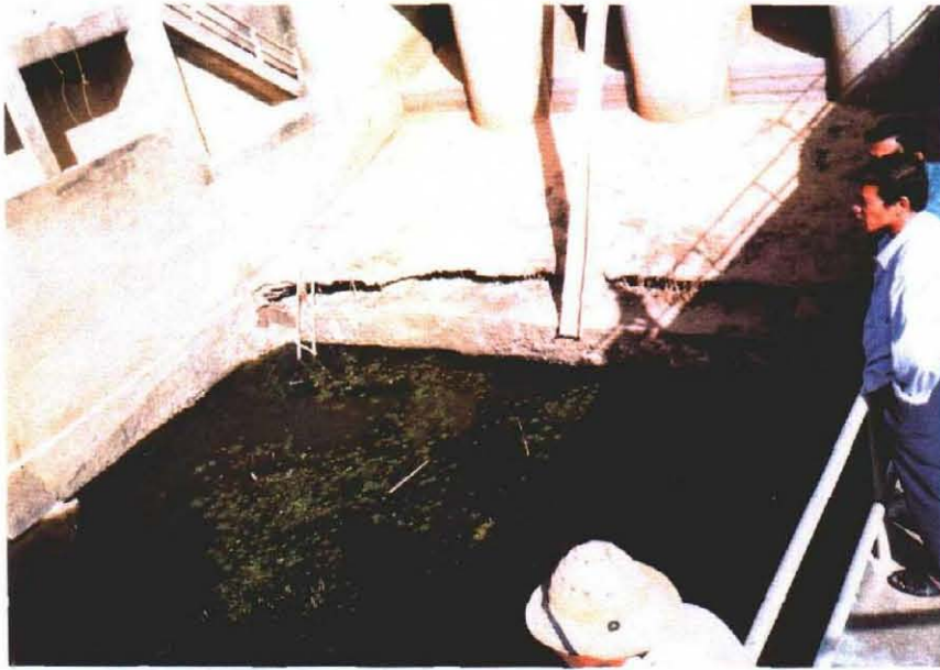
コンポントマ頭首工 (基礎が侵蝕されている)
