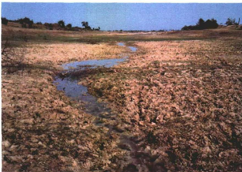
幹線水路 (逆勾配になっている)
