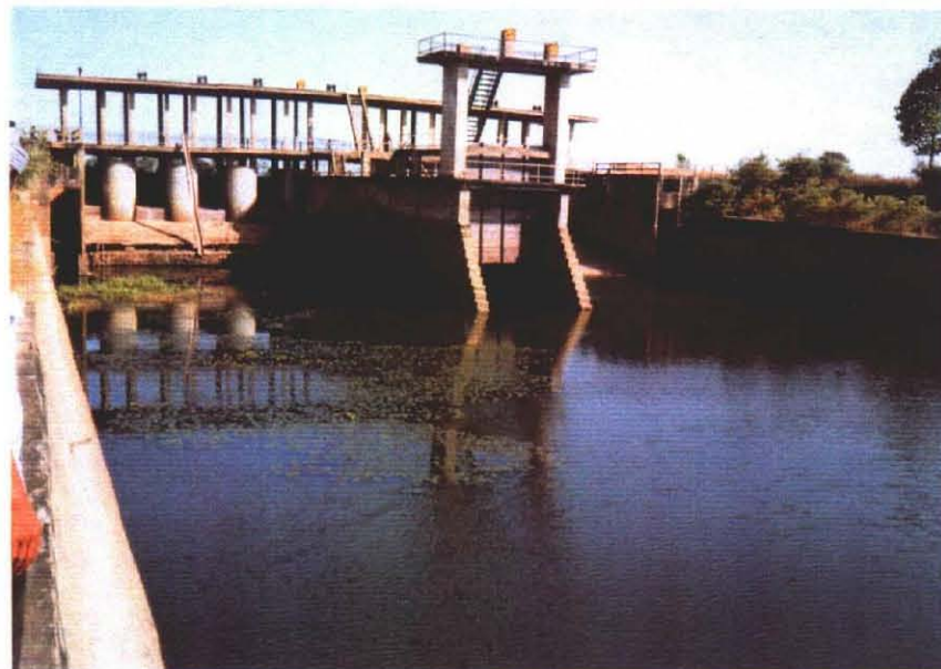
コンポントマ頭首工 (下流側)
