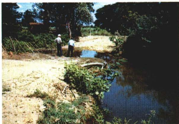
道路横断工建設前の状況
