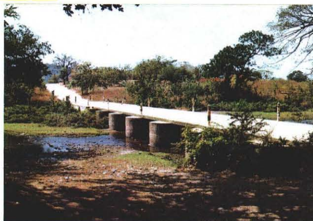
橋建設後の状況
