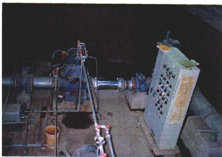
ポンプ小屋内部
