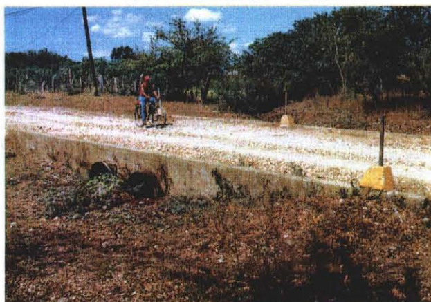
道路横断工建設後の状況
