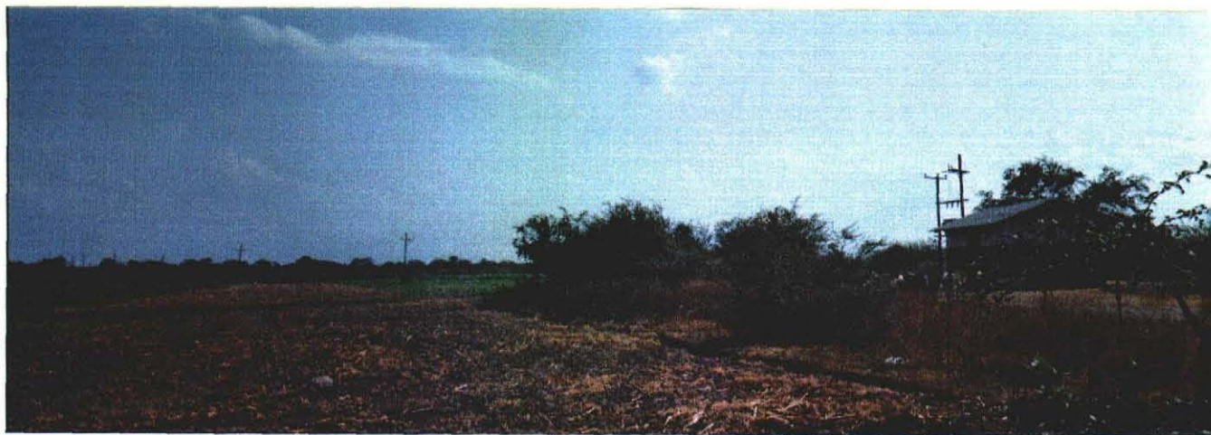
ポンプ小屋および送電線
