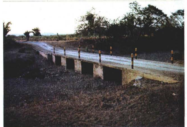
橋建設後の状況
