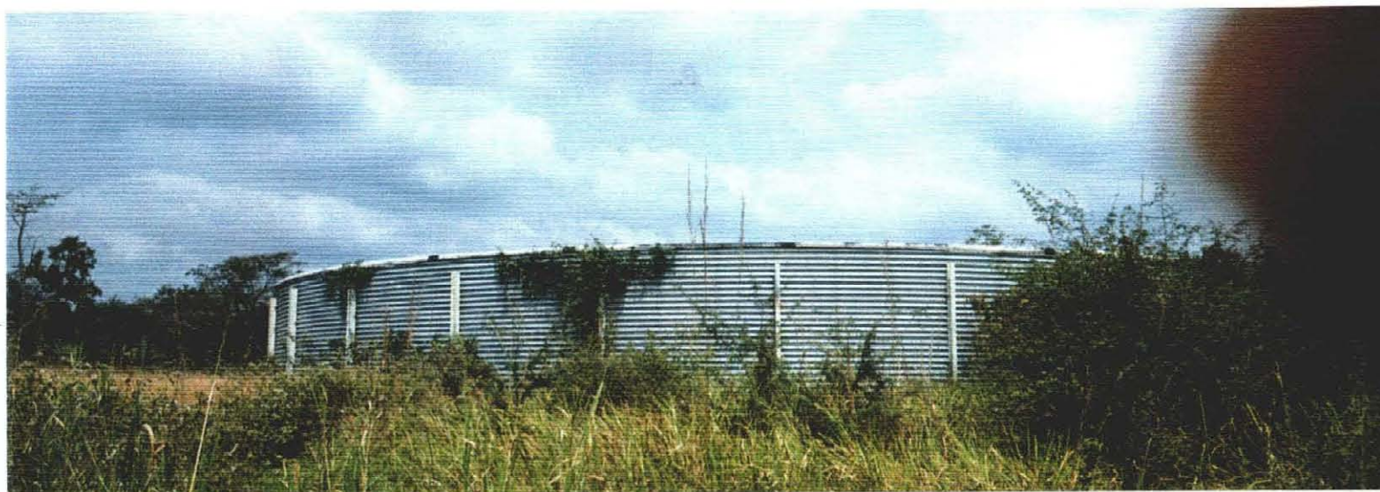
Réservoir de Distribution
