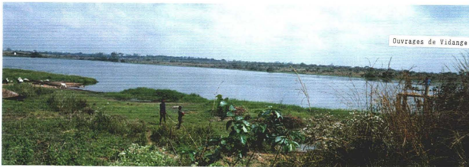
Réservoir du Barrage
