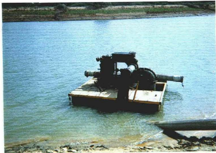
Une Station de Pompage
