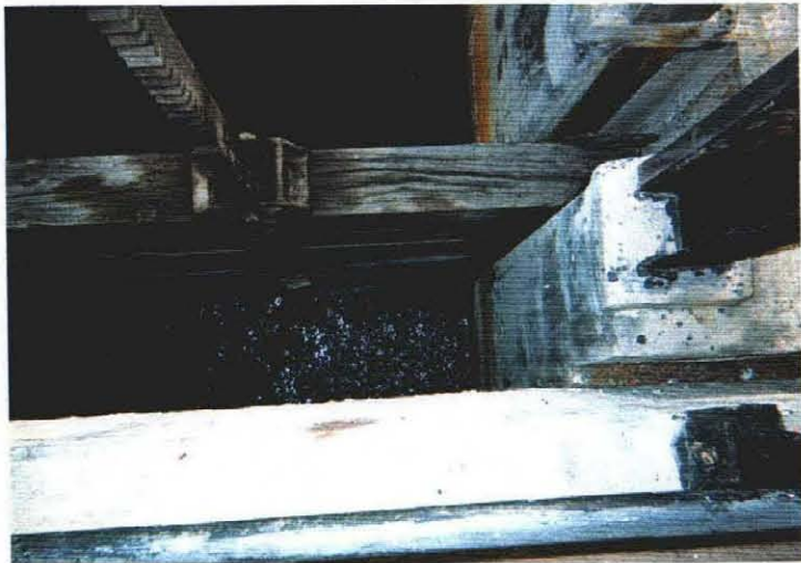
Vue d'une Vanne à glissement
