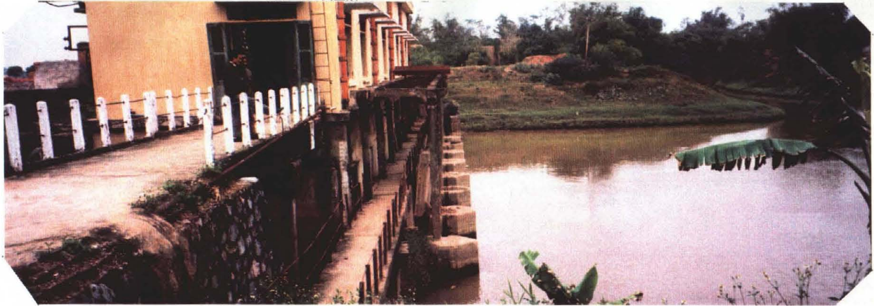
上①Nhu Quynh Irri-Project 灌漑23,000ha P-8台 1964年設置 ルーマニア製 機場吸 い込み側 下②機場吸い込み側全景
