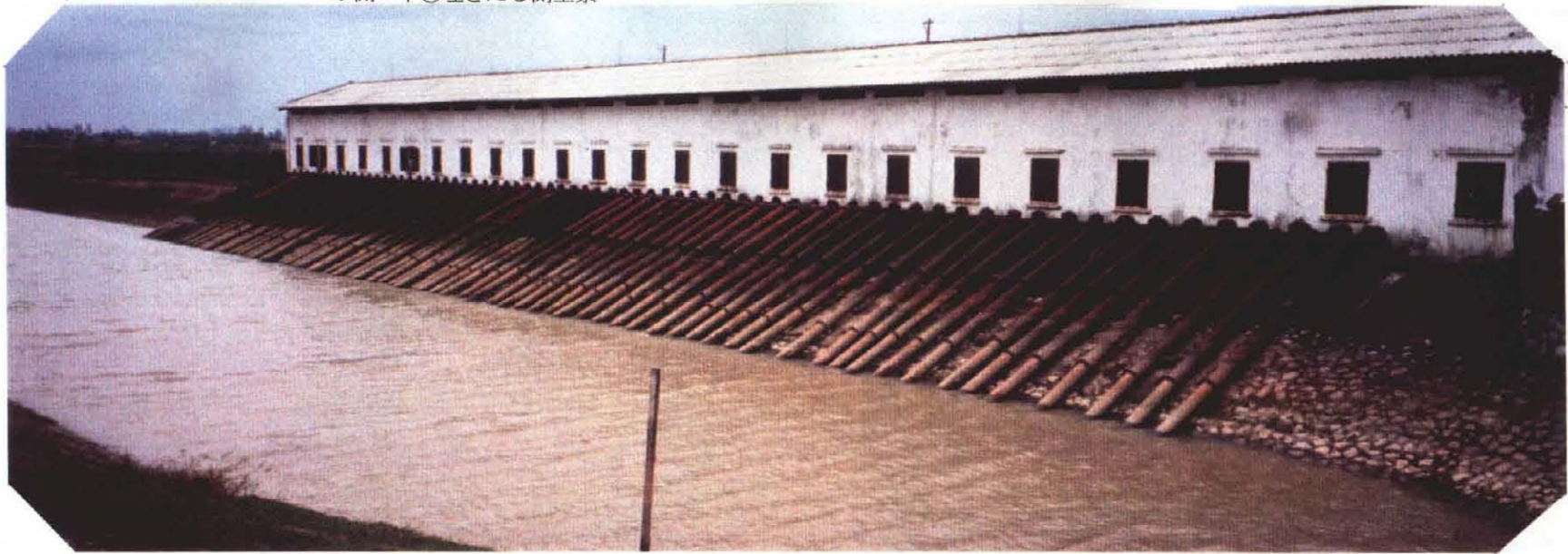
上⑤Tan Chi-Irri-Project 灌漑 5170ha p-68台 1974年設置 ベトナム製 機場吸い込み側 下⑥吐きだし側全景
