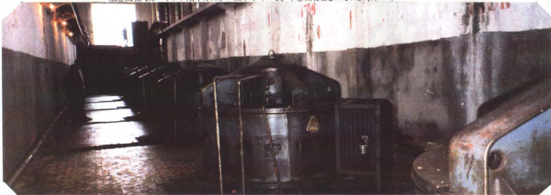
上③機場内部 ポンプ効率は60% に低下している。下④機場吐きだし口排水ゲート
